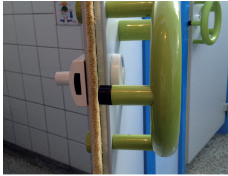
Abb. 2: WC-Tür mit integriertem Klemmschutz mit Bürste
