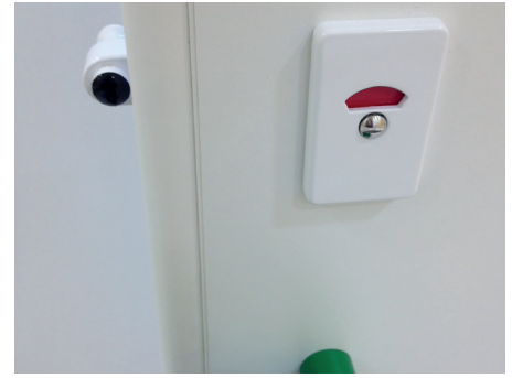
Abb. 3: WC-Tür mit integriertem Klemmschutz mit Weichlippenprofil
