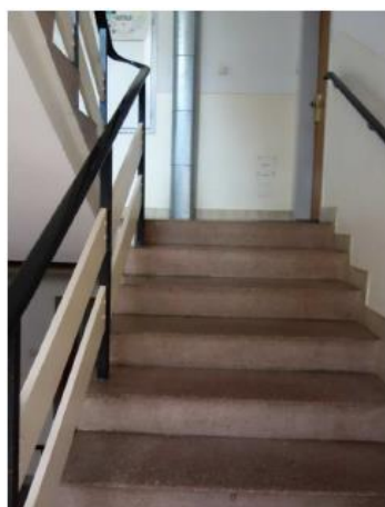
Foto: Stiegenhaus vom 20.09.2018
