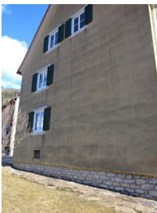
Abbildung 13: Foto Westansicht; aufgenommen am 27.02.2020
