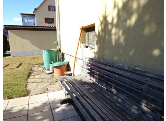
Abbildung 20: Foto Traufe, Vorplatz zu Kellerzugang; aufgenommen am 27.02.2020
