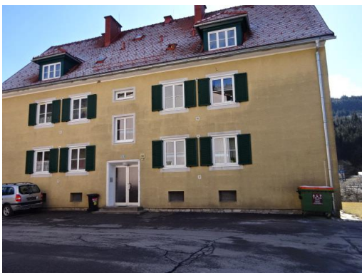
Abbildung 6: Foto Wohnhaus Nordansicht; aufgenommen am 27.02.2020
