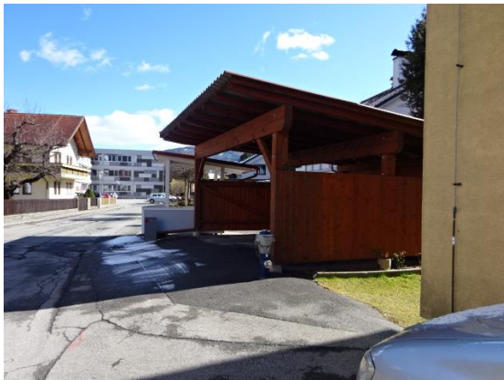
Abbildung 21: Foto Carport; aufgenommen am 27.02.2020
