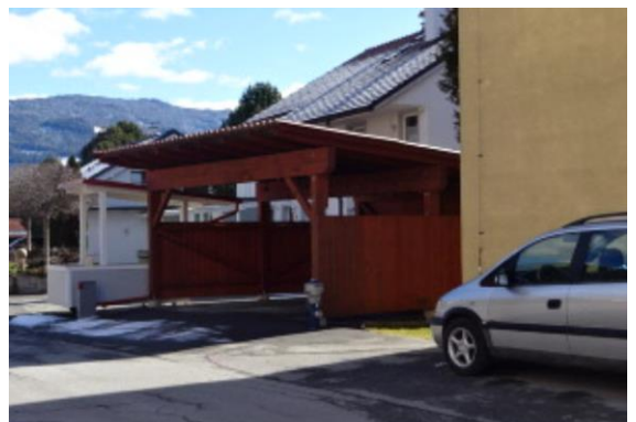
Abbildung 7: Foto Carport; aufgenommen am 27.02.2020
