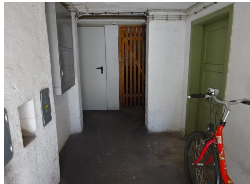
Abbildung 12: Foto Kellergeschoss; aufgenommen am 27.02.2020
