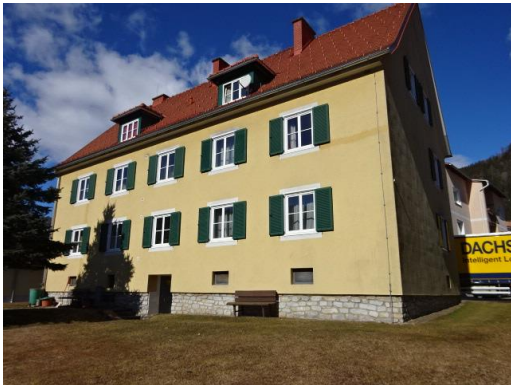
Abbildung 9: Foto Südansicht; aufgenommen am 27.02.2020
