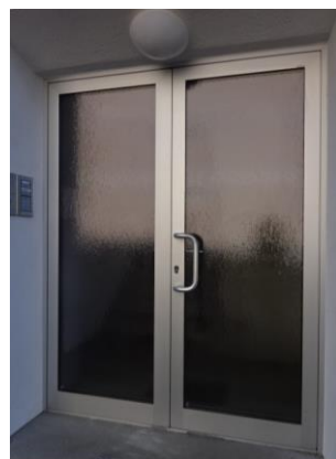
Abbildung 14: Foto Zugangstüre; aufgenommen am 27.02.2020
