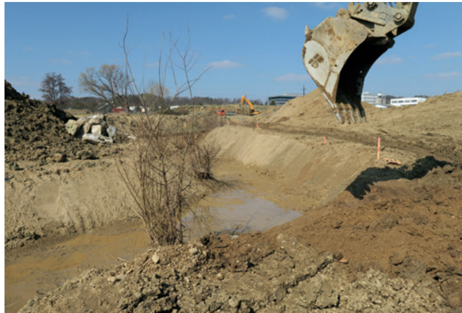
BaggerfahrerInnen sind meistens Schlüsselfiguren bei der Ausgestaltung ökologischer Maßnahmen auf der Baustelle.
