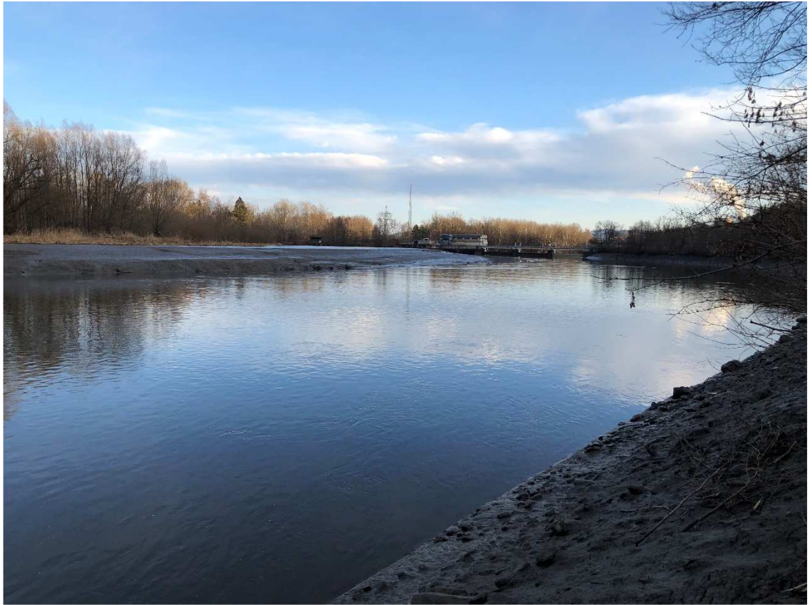
Abbildung 14 Stauraum Obervogau mit Absenkung auf freien Durchfluss im Jänner 2021
