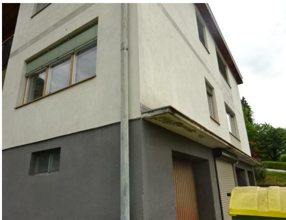
Abbildung 40: Foto Fassadenschäden; aufgenommen am 17.05.2022
