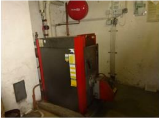
Abbildung 24: Foto Heizraum, aufgenommen am 17.05.2022
