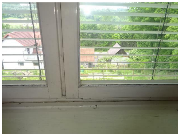
Abbildung 43: Foto Fensterkonstruktion, aufgenommen am 17.05.2022
