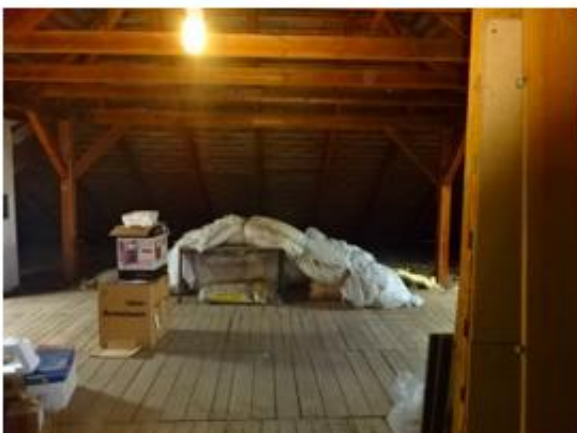
Abbildung 34: Foto Dachboden, aufgenommen am 17.05.2022
