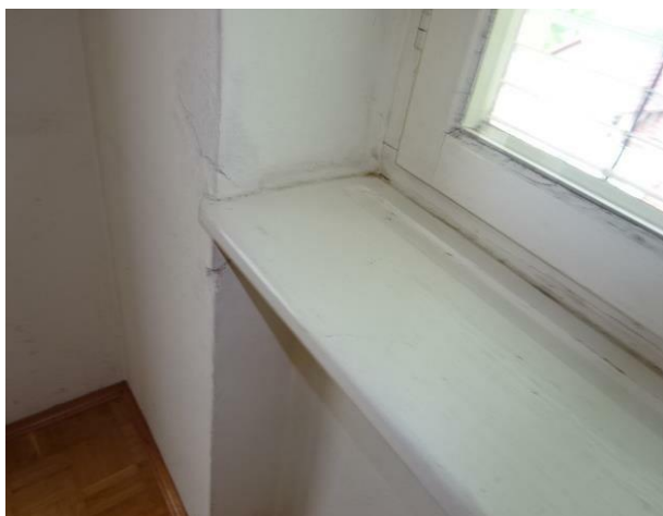
Abbildung 44: Foto Fensterkonstruktion, aufgenommen am 17.05.2022
