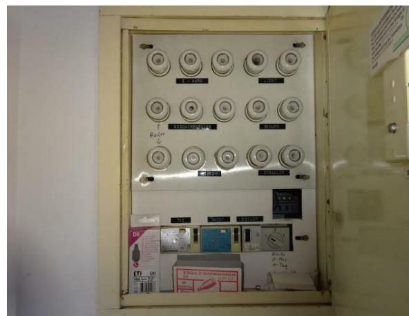
Abbildung 45: Foto E-Verteiler, aufgenommen am 17.05.2022
