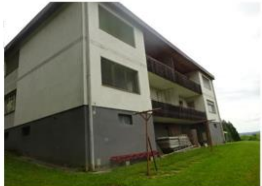
Abbildung 21: Foto Westansicht, aufgenommen am 17.05.2022
