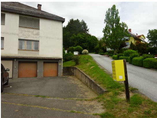
Abbildung 46: Foto Fläche vor den Garagen, Zugang, Stützmauer, aufgenommen am 17.05.2022
