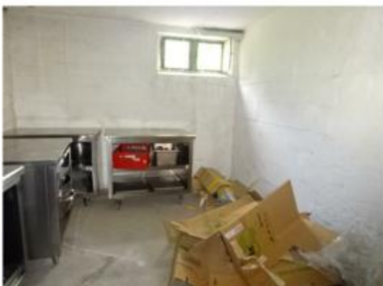
Abbildung 22: Foto Kellerraum, aufgenommen am 17.05.2022
