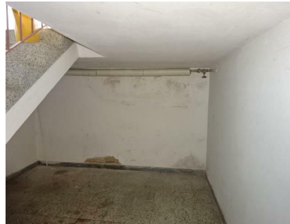
Abbildung 41: Foto Feuchteschäden, aufgenommen am 17.05.2022
