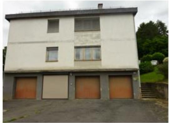
Abbildung 19: Foto Südansicht, aufgenommen am 17.05.2022
