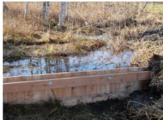
Sofort nach dem Einbau der Spundwand steigt das Wasser
