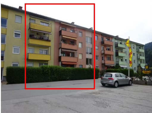
Abbildung 8: Foto Wohnhaus Westansicht; aufgenommen am 15.06.2022
