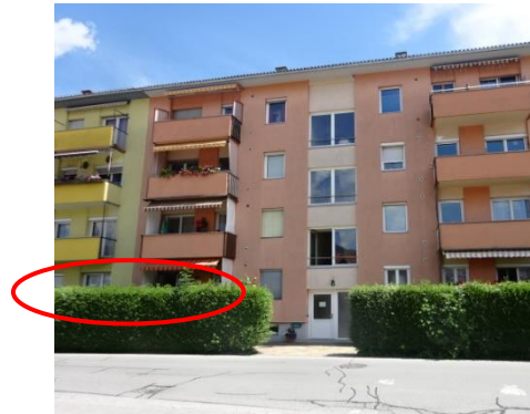
Abbildung 11: Foto Westansicht; aufgenommen am 15.06.2022
