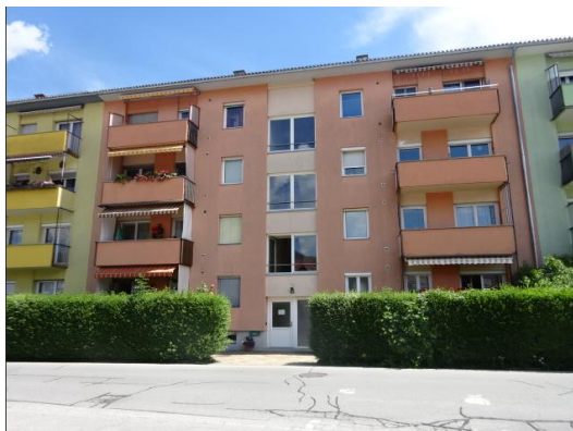
Abbildung 6: Foto Zugang von der Grazer Straße (Westen); aufgenommen am 15.06.2022
