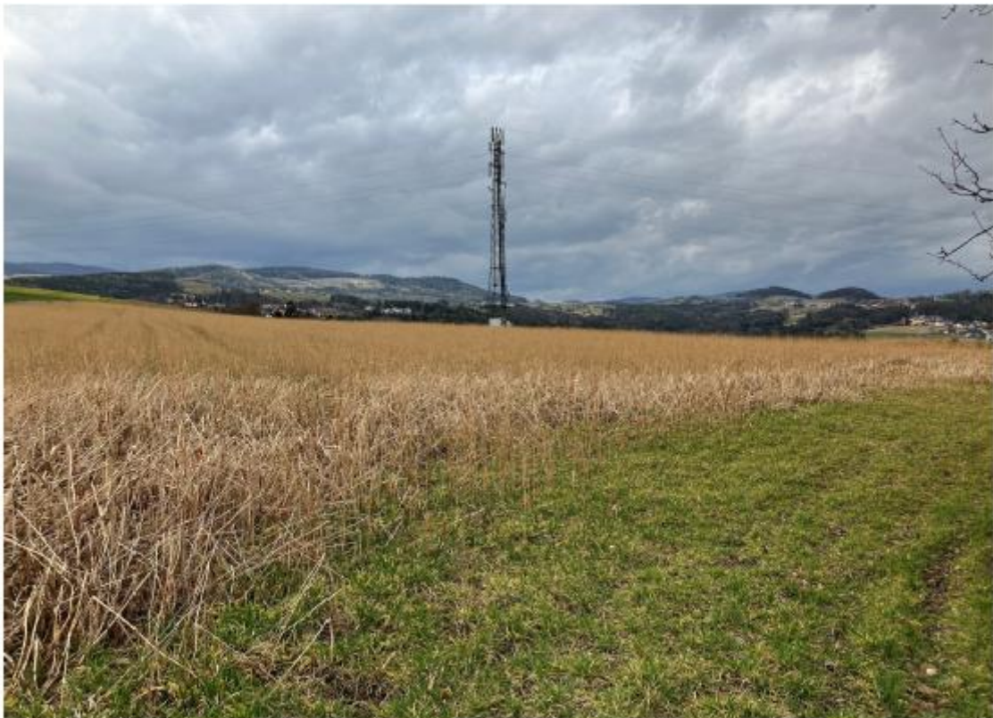
Abbildung 2 - Lage um 110 kV-Freileitungsmast, Ackerbau
