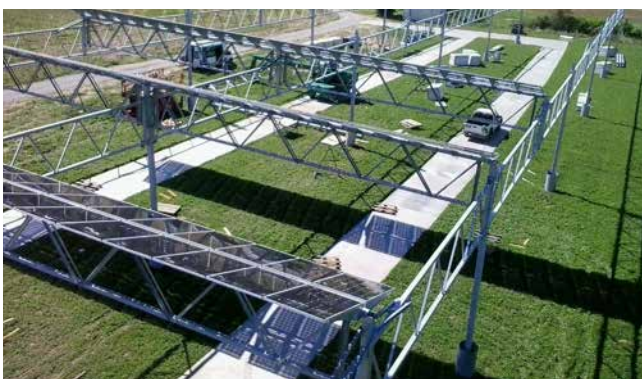
Bild 48: Baustraßen zur Vermeidung von Bodenverdichtung.
