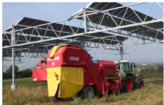
Bild 34: Hoch aufgeständerte Anlage mit Möglichkeit zur Bewirtschaftung mit dem Kartoffelvollernter.
