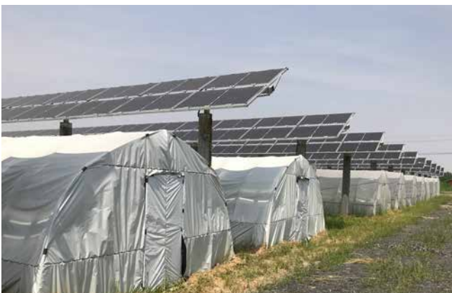
Bild 36: PV-Module über einem Folientunnel. © BayWa r.e.
