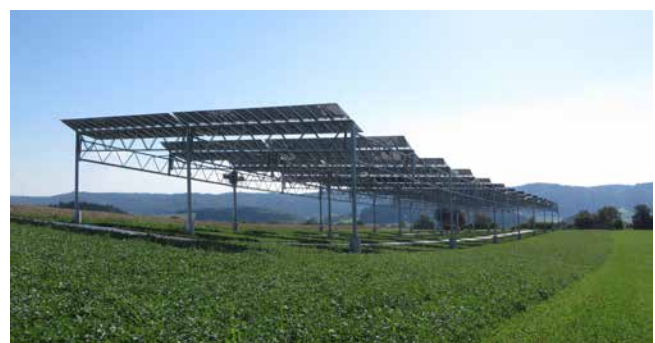
Bild 3: Agri-PV-Forschungsanlage des Fraunhofer ISE am Bodensee.
