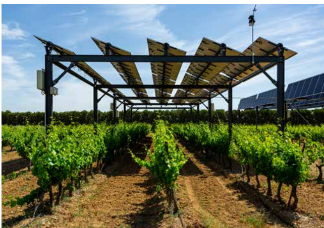
Bild 22: Agri-PV mit nachgeführten Modulen in Frankreich. © Sun'Agri
