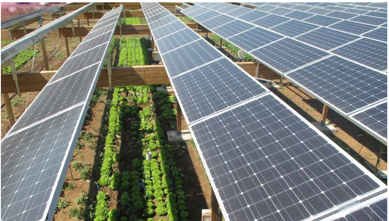
Bild 16: Studie mit verschiedenen Salatsorten in der Agri-PV-Forschungsanlage der Universität von Montpellier, Frankreich.
