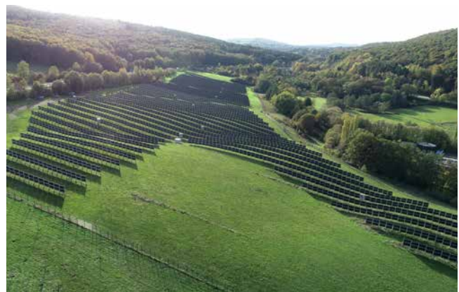
Bild 47: Solarpark Eppelborn-Dirmingen mit 2 MW p mit vertikalen Solarzäunen von Next2Sun. © Next2Sun GmbH
