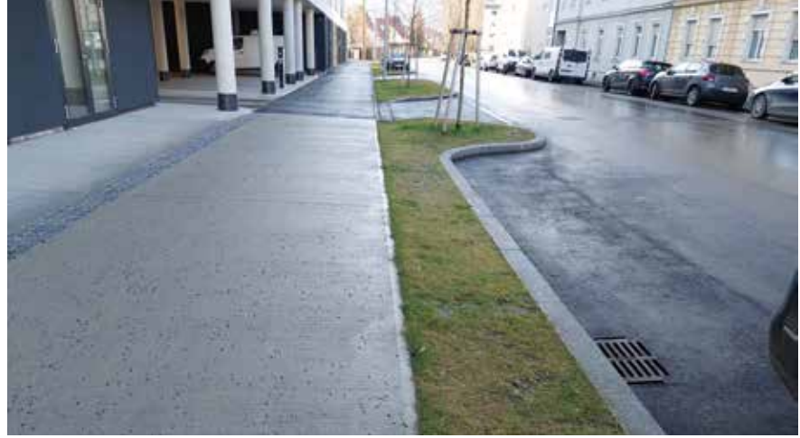
Abb. 5: Neu errichtete Baumstandorte in der Grazer Handelstraße: Durch die Verbindung der Baumscheiben mit einem Grünstreifen steht das gesamte Wasser des Gehsteigs den Bäumen zur Verfügung. Der eingebaute Schotterrasen gewährleistet eine dauerhafte Durchlässigkeit trotz der querenden Fußgänger:innen von den parkenden Autos © Stadt Graz, T. Stoisser (2023)
