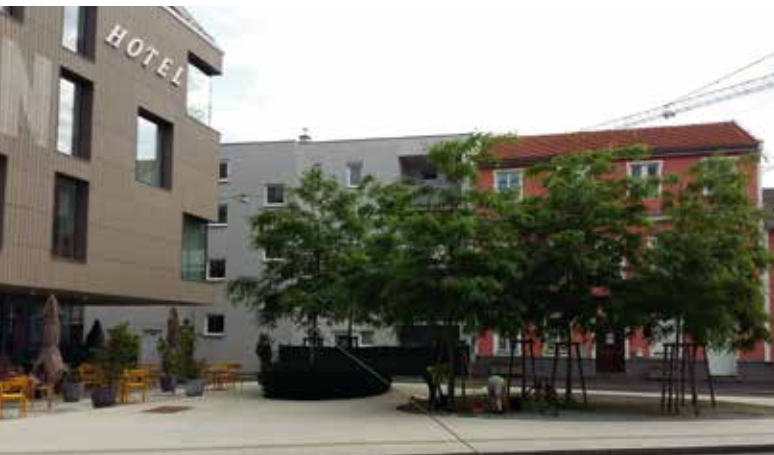
Abb. 3: Gleditsia triacanthos in wassergebundener Decke vor dem Grazer Lendhotel: Die wassergebundene Decke wurde mit Struktursubstrat (32/64 Kantskorn und Pflanzkohle/Sandgemisch trocken abgemischt) in einer Stärke von 60 cm unterbaut. Der gesamte Platz entwässert in die Baumscheiben. Die Bäume sind auf dem Foto im dritten Standjahr © Stadt Graz, T. Stoisser (2021)
