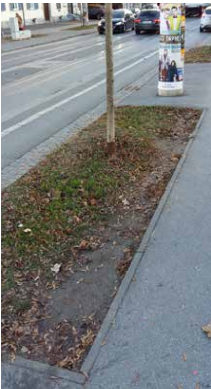
Abb. 1: Baumscheibe in der Eggenberger Allee: Hier kann das Regenwasser theoretisch in der Grünfläche versickern. Allerdings ist durch das erdbasierte Substrat und die ständige Belastung der Standort verdichtet, die Versickerung und der Gasaustausch sind stark reduziert, die Entwicklung des Baumes mangelhaft © Stadt Graz, T. Stoisser (2016)
