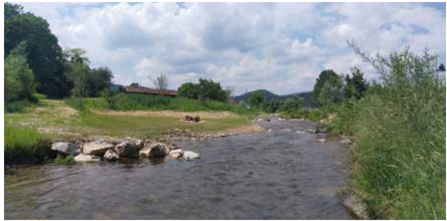
Abb. 3: Hochwasserschutz mit Rücksichtnahme auf die Gewässermorphologie © A14
