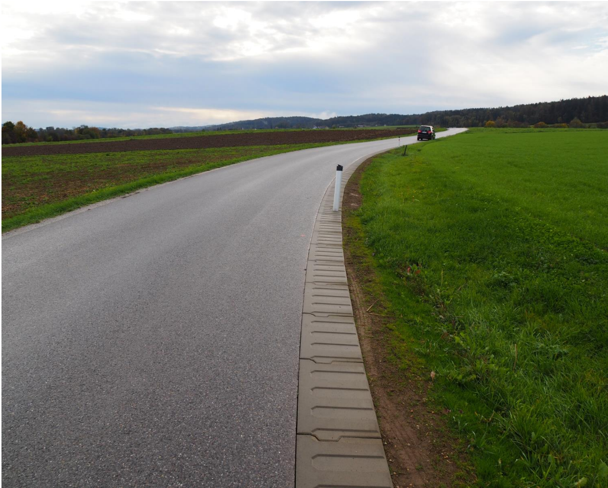
Abbildung 15: Bankett mit Betonformsteinen
