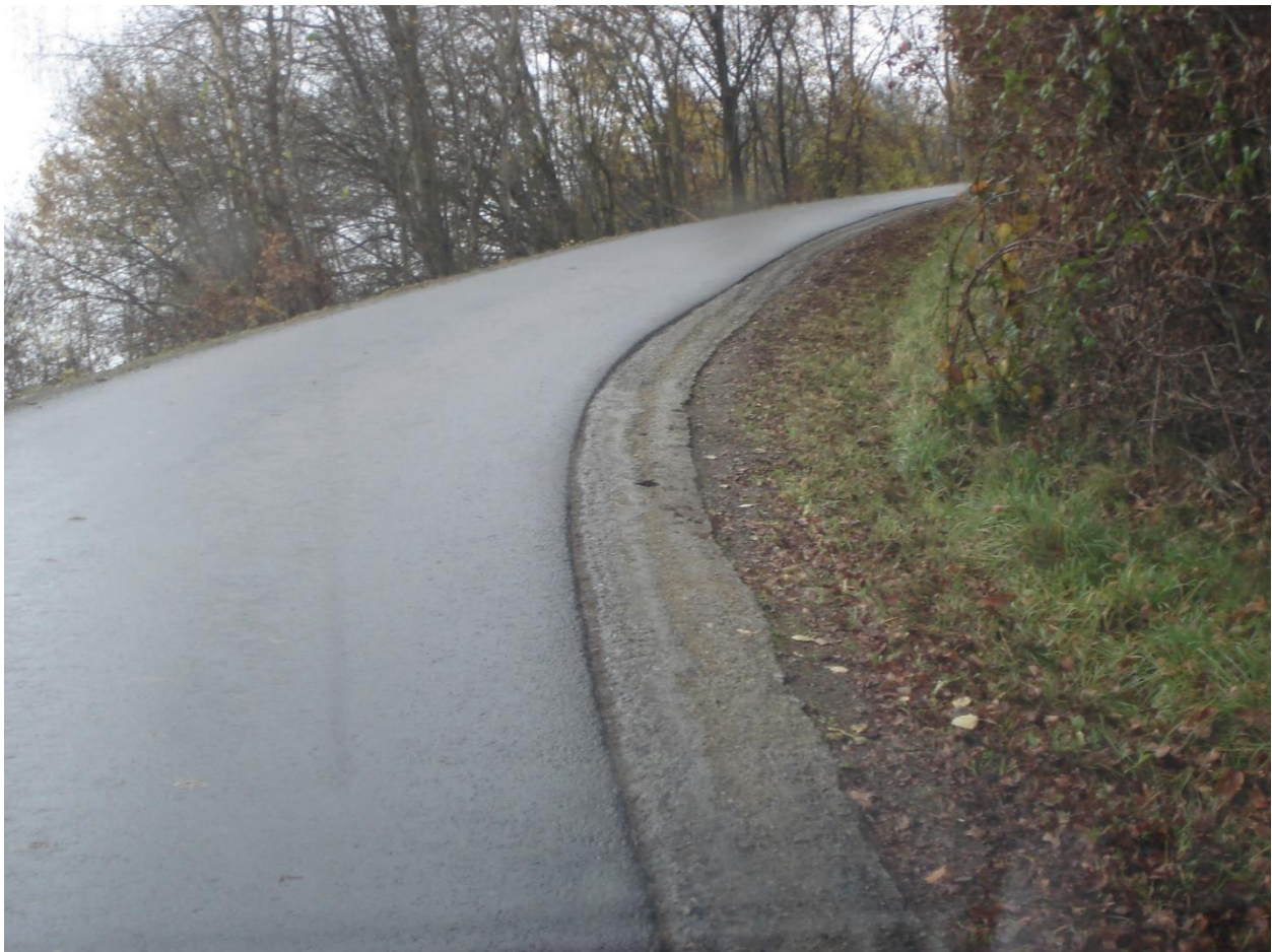
Abbildung 11: Bindemittelstabilisiertes Bankett
