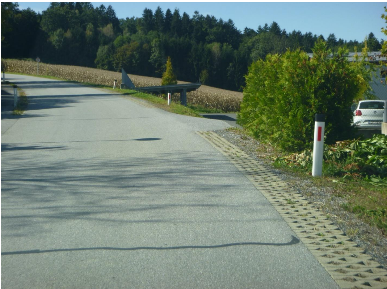
Abbildung 13: Bankett mit Rasengittersteinen
