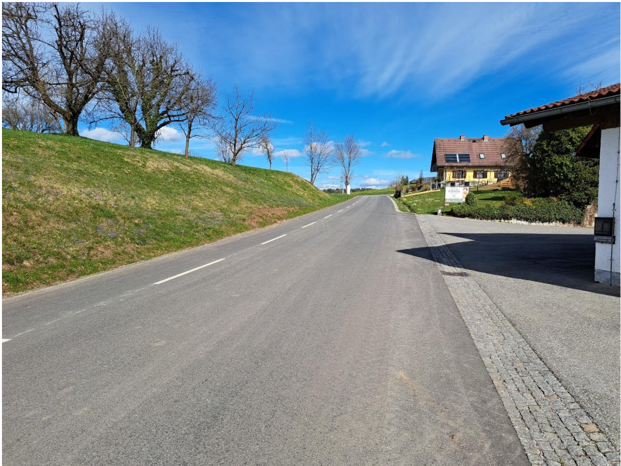
Abbildung 25: Unzulässige Markierung eines Gehweges ohne weitere Leiteinrichtung
