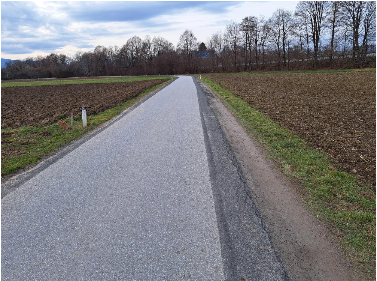
Abbildung 16: Beispiel für eine nicht fachgerechte Verbreiterung einer Straße
