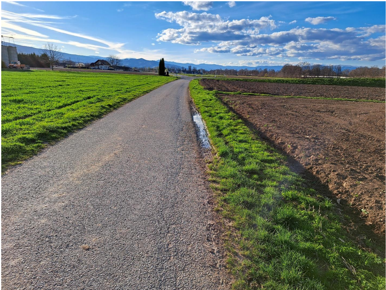
Abbildung 17: Größere Wasseransammlung im Bankettbereich
