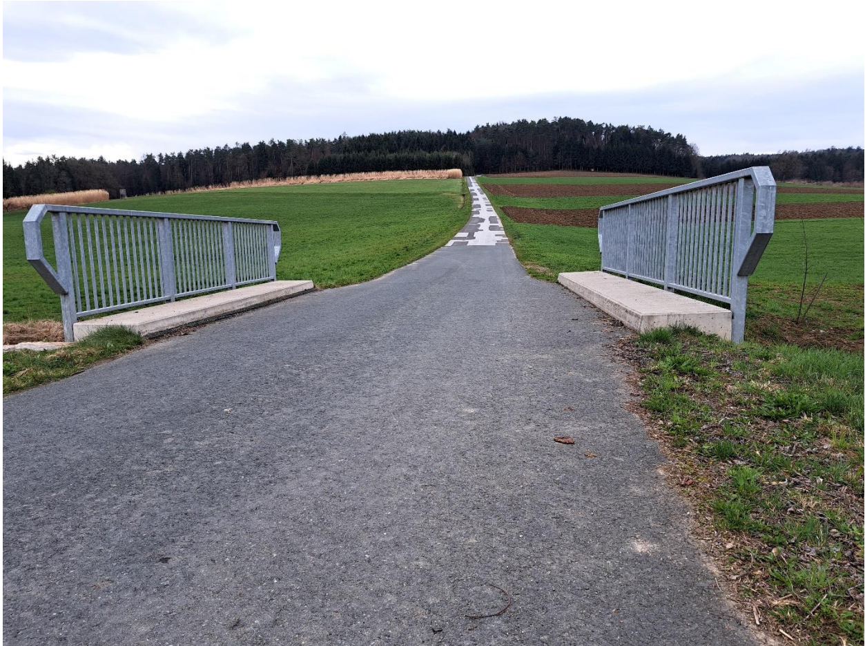
Abbildung 28: Ländliche Brücke mit den Betonrandbalken und außenmontierten Geländern
