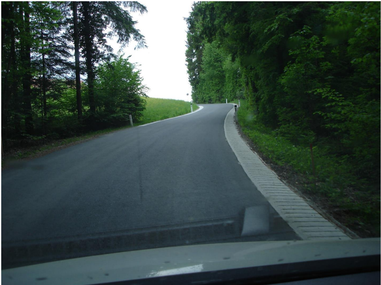
Abbildung 12: Straße mit Ortbetonbankett
